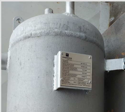
Inovativni projekt uparjalnika klora UK 200 za pripravo pitne vode. Izdelava: Zarja Koviš d. o. o., Kamnik, 2021. Naročnik: Controlmatik ABW, Domžale, d. o. o., za Arabsko republiko Egipt. Foto: arhiv Zarja Koviš
