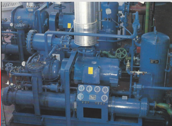
Vijačni hladilni agregat Howden, Perutninski kombinat Pivka, 1985. Razvoj in izvedba Zarja, p. o. Foto: arhiv Zarja.
